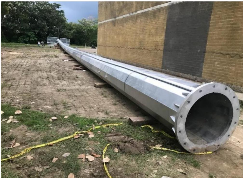
*Anexo 19. mástil ensamblado en posición horizontal.*
