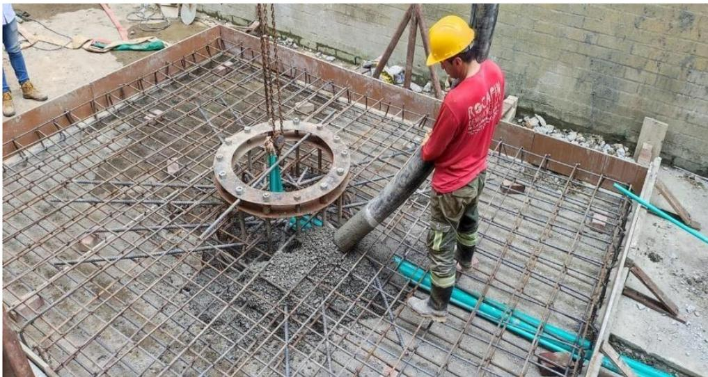
*Anexo 15. Vaciado de concreto in situ.*
