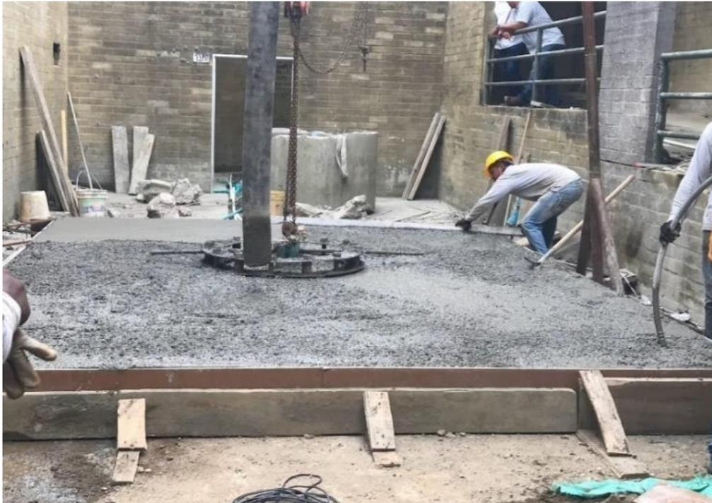
*Anexo 16. Concreto vaciado en su totalidad en una de las pilas.*
