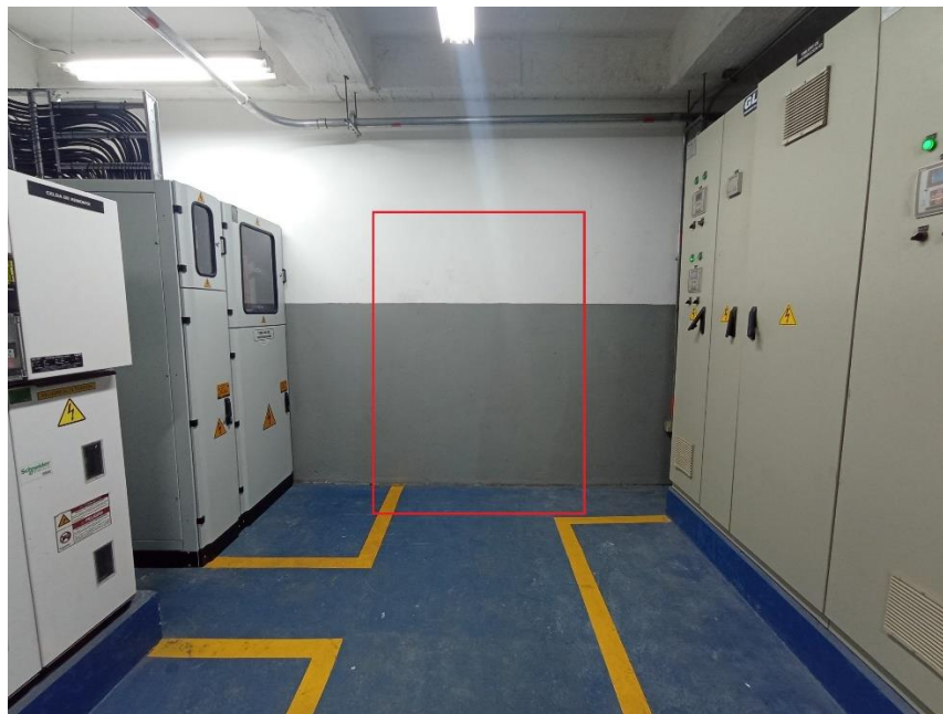
Figura 40. Espacio disponible para los nuevos equipos.
