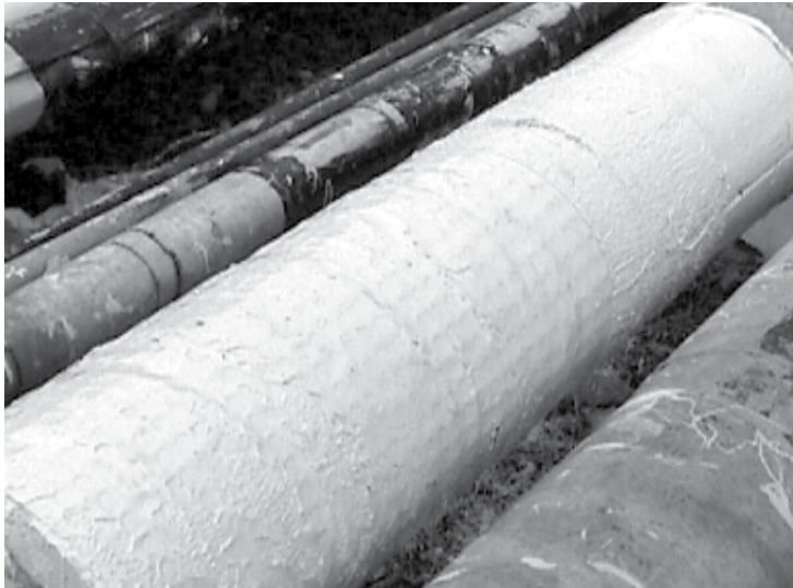
Figura 9. Primera prueba de campo del material compuesto para reemplazar la cubierta de aluminio y mejorar la protección de las cañuelas contra la humedad. (Planta de Balance-GCB, Junio/98)
