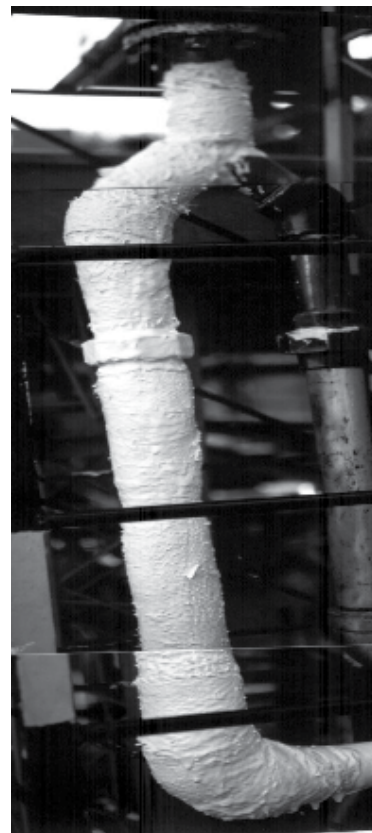
Figura 10. Instalación del material compuesto, en planta piloto-ICP, directamente sobre la superficie caliente de la tubería. Julio de 1999
