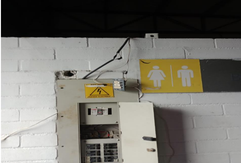
Fig. 53 modificación de tablero de distribución.
