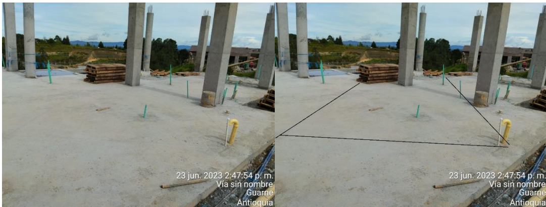
Figura 10. Cortes de dilatación
