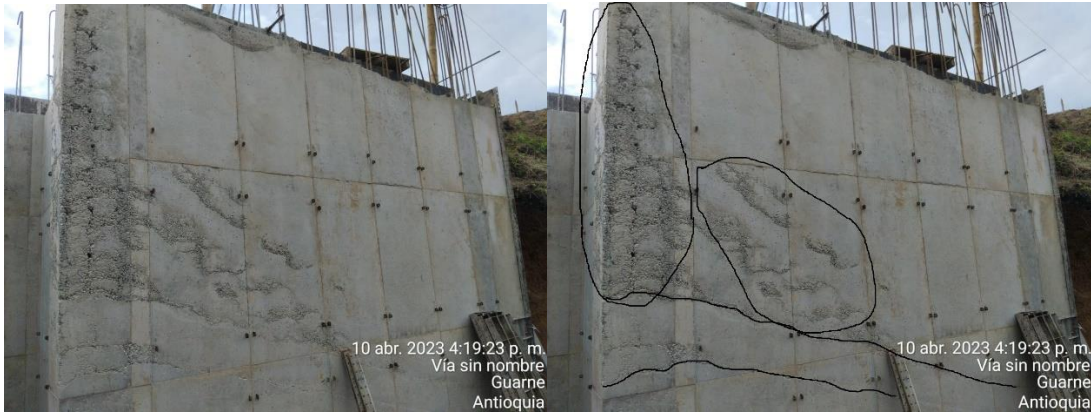
Figura 4. Muro de contención
