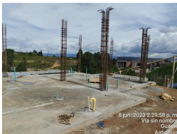
Figura 8. Losa fraguada
