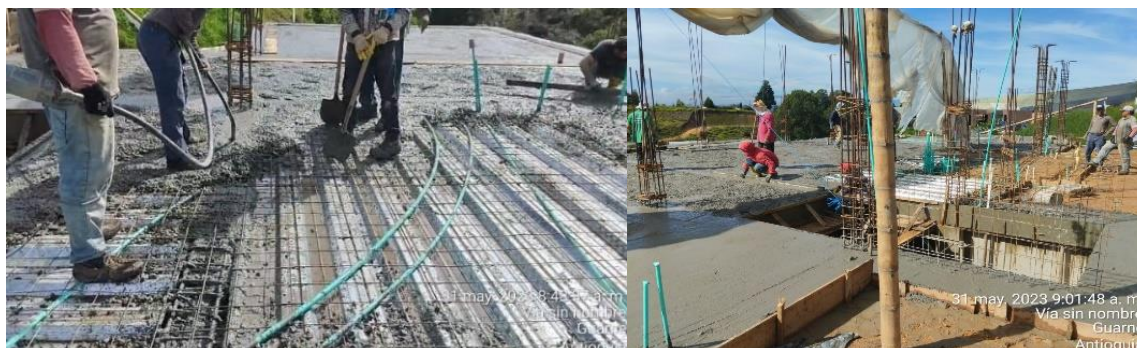
Figura 7. Vaciado de losa-vibración y nivelación
