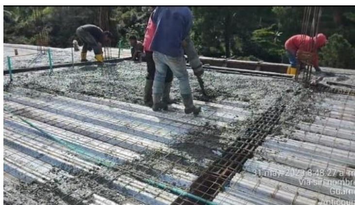
Figura 6. Vaciado de losa-Bomba
