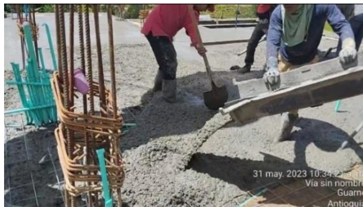
Figura 5. Vaciado losa entrepiso
