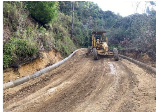
d. Ampliación de la vía según ancho establecido en los diseños
