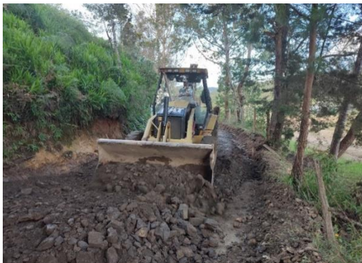
c. Eliminación de elementos gruesos con retroexcavadora
