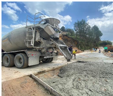
a. Disposicion de concreto tipo premezclado
