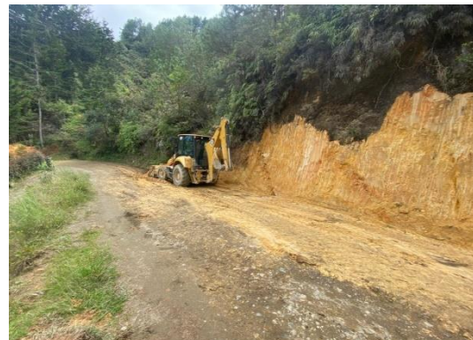
d. Ampliación de la vía según ancho establecido en los diseños
