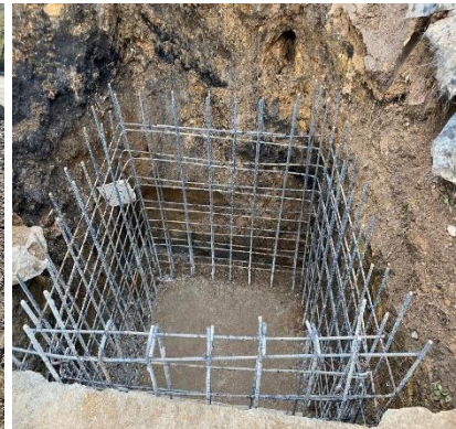
c. Acero corrugado obras transversales
