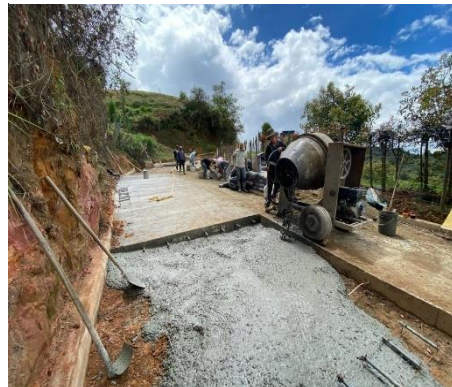
b. Disposicion de concreto mezclado en obra
