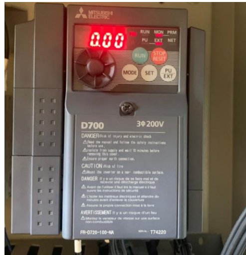
Imagen 26. Variador de velocidad en funcionamiento normal, mientras no activan el sistema de transmisión.
