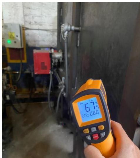
Imagen 42. Evidencia de toma con infrarrojo la temperatura de paredes laterales.
