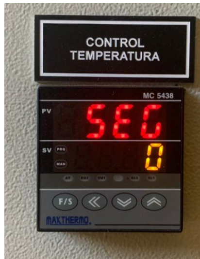
Imagen 30. Segmento actual en el que se encuentra la curva actualmente.
