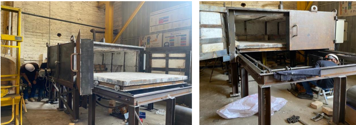
Imagen 16. a) Anclaje de mesa en el suelo. b) Instalación del control por parte de Logitec.
