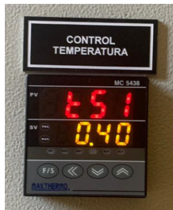
Imagen 35. Tiempo que sostendrá esta temperatura, considerando un rango alto de \pm 50^{\circ}\text{C} en consideración del quemador ON/OFF que se tiene.
