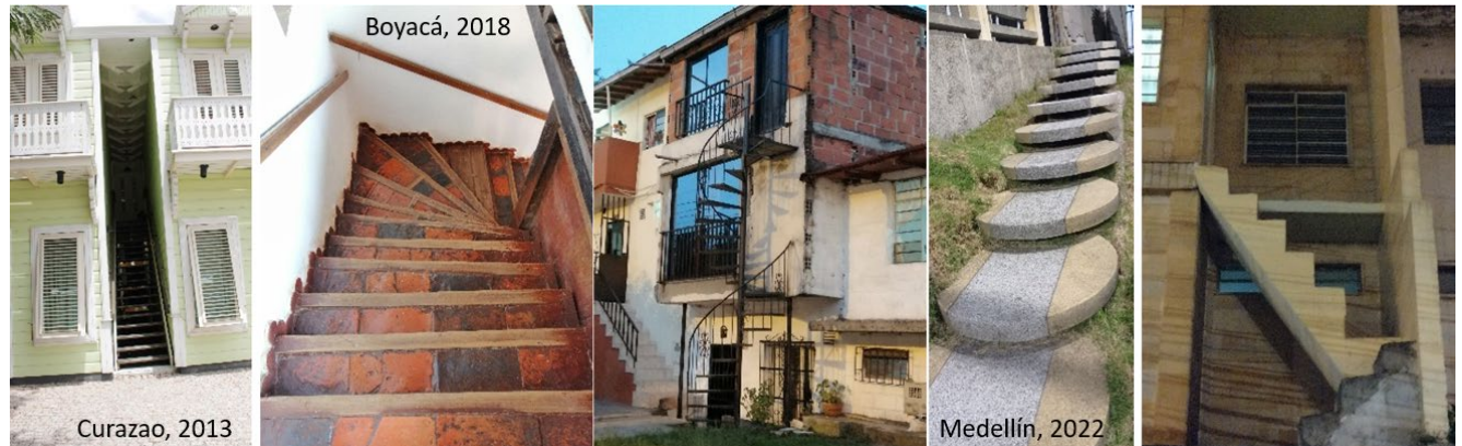
Figura 5. Inventario de escaleras
