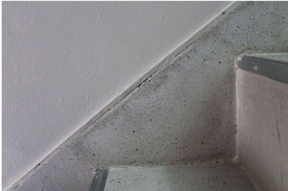
Figura 44. Registro fotográfico - Escaleras Casa D I
