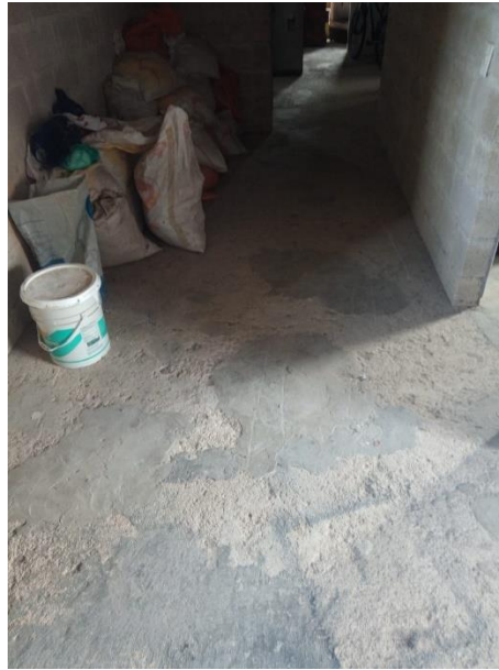
Figura 5. Mejoramiento de Vivienda (Cambio de Piso) antes Fuente: Elaboración Propia,2023
