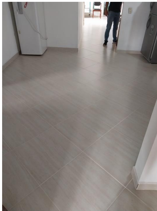
Figura 6. Mejoramiento de Vivienda (Cambio de Piso) Después Fuente: Elaboración Propia,2023
