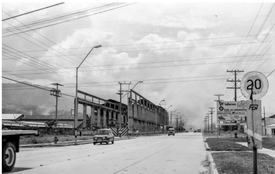
Vista de la fábrica de Simesa en 1976
