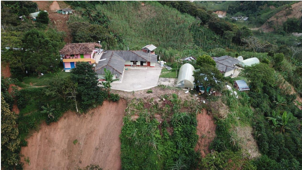
Ilustración 23. Desastres naturales por torrencial de lluvias. Vereda Santa Gertrudis, mayo de 2021
