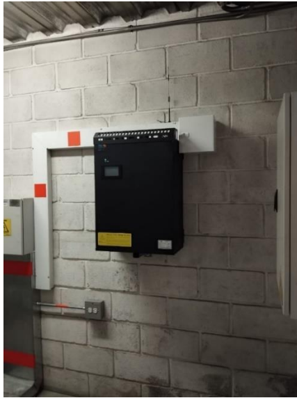
Figura 21. Instalación exitosa de filtro activo en EDS Belén.
