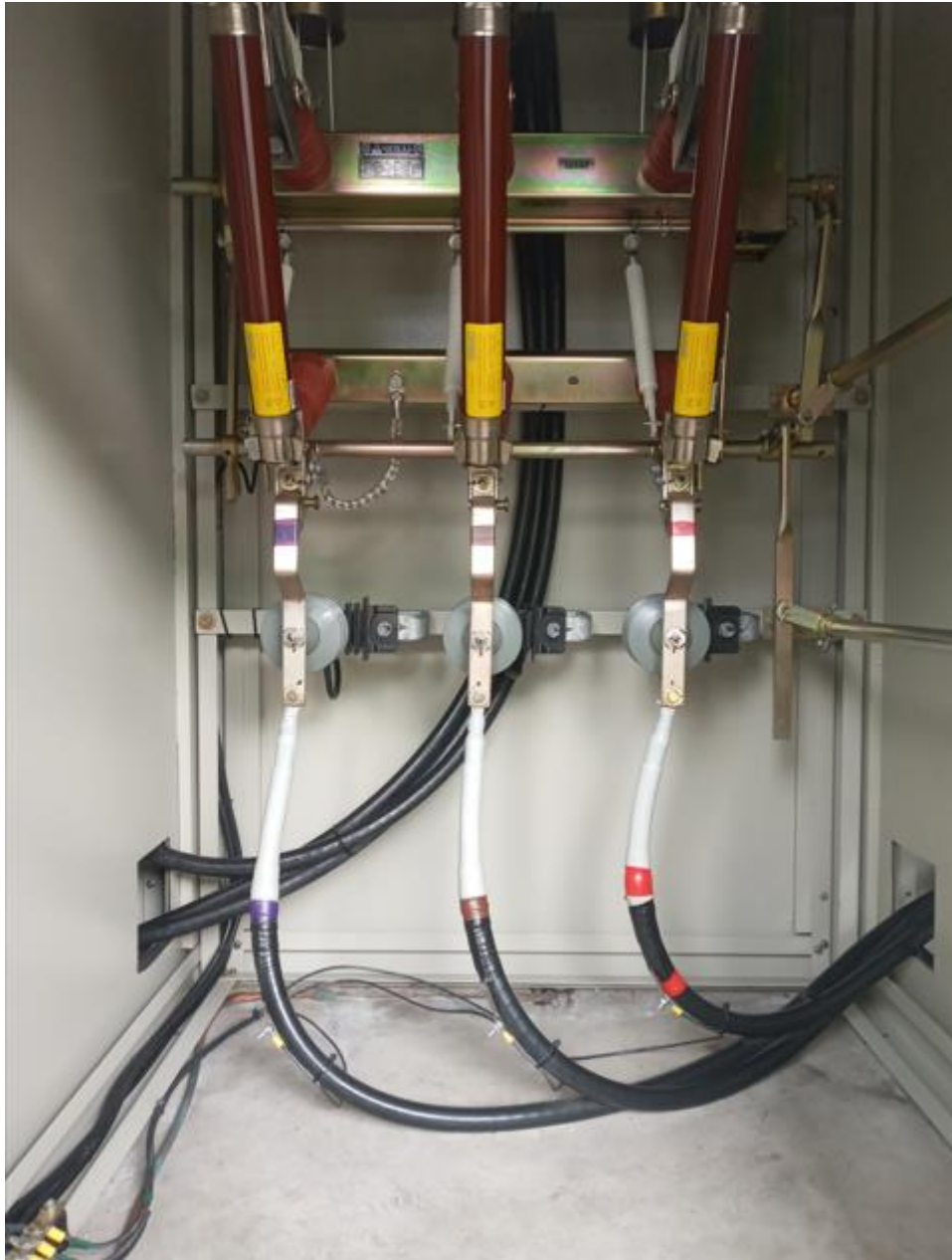
Figura 5. Seccionador SOCOL.
