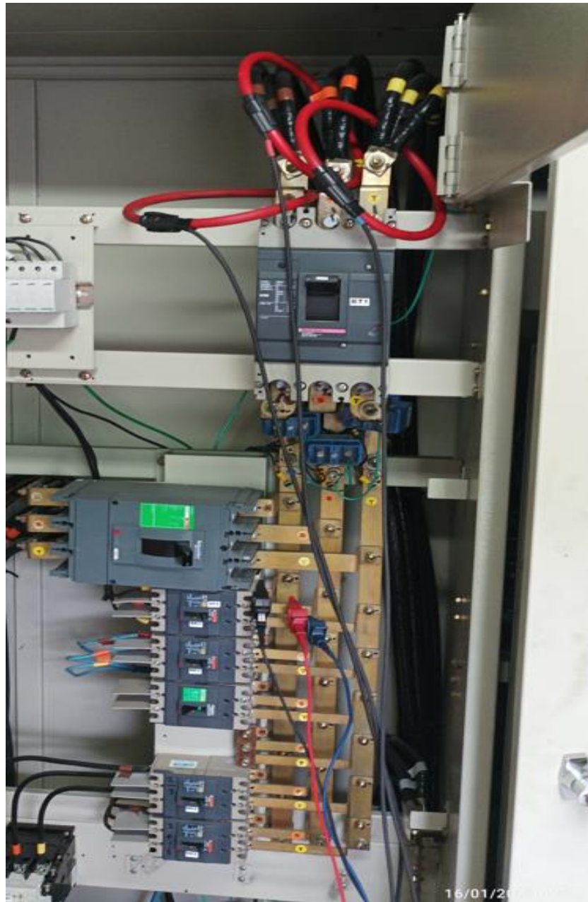
Figura 8. Montaje en sitio del analizador de redes.
