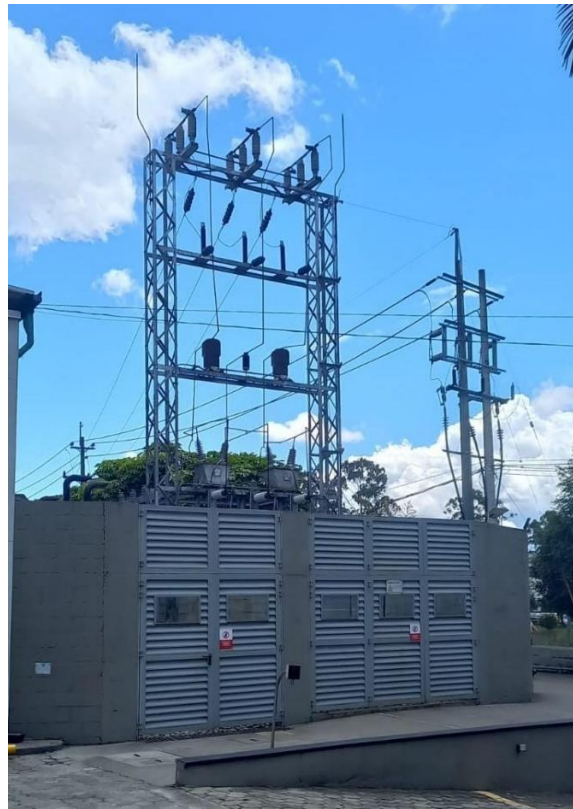
Fig. 18. Pórtico antes de su modificación
