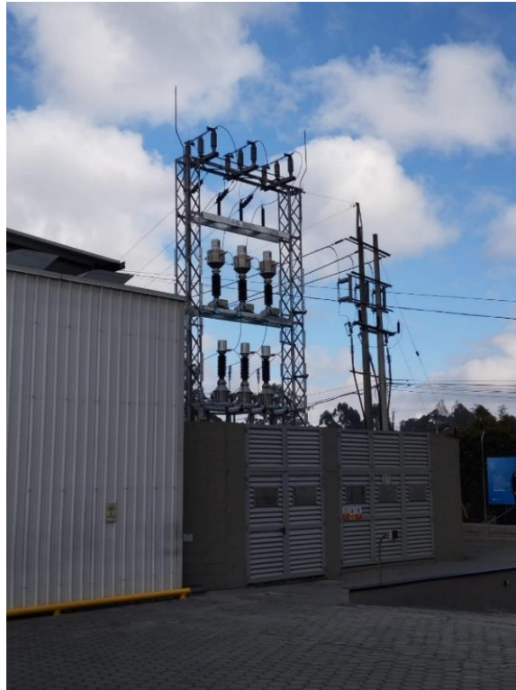
Fig. 19. Pórtico después de su modificación
