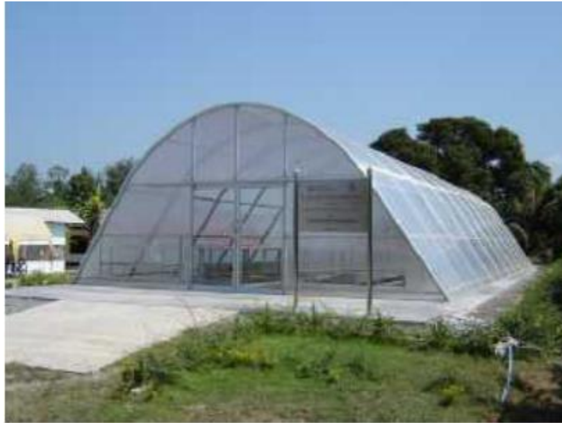
Figura 3. Secador solar de polycarbonato tipo túnel. Tomado de [8]
