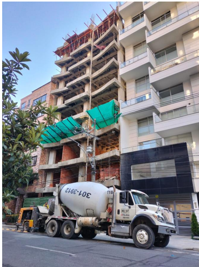
Fachada Lateral del Proyecto Puerto Bali
