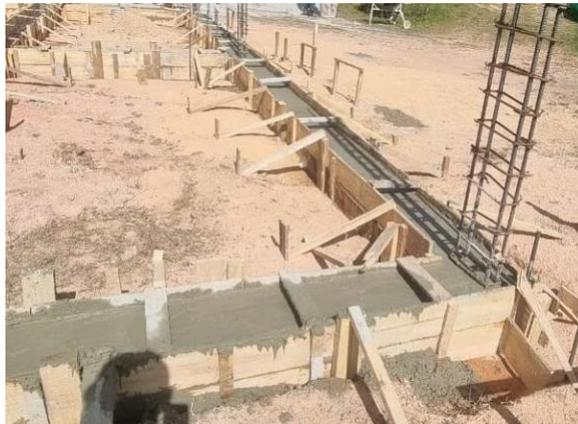
**Fotografía 4** - Inicio de vaciado de vigas de fundación - octubre 9 de 2023
