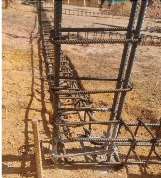
**Fotografía 3** – Colocación de vigas de fundación armadas anteriormente - octubre 7 de 2023
