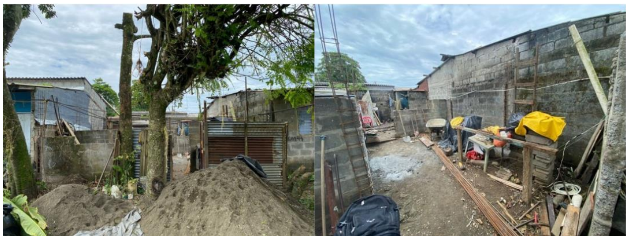
Figura 8. Interventoría de la obra (durante)
