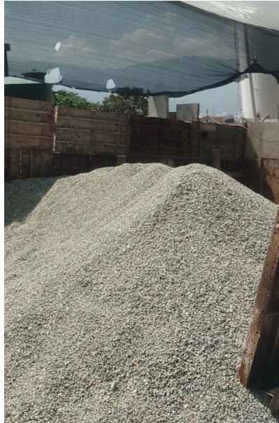
Figura 8. Almacenamiento de agregado grueso en obra Villa Gabriela ( Elaboración propia ).
