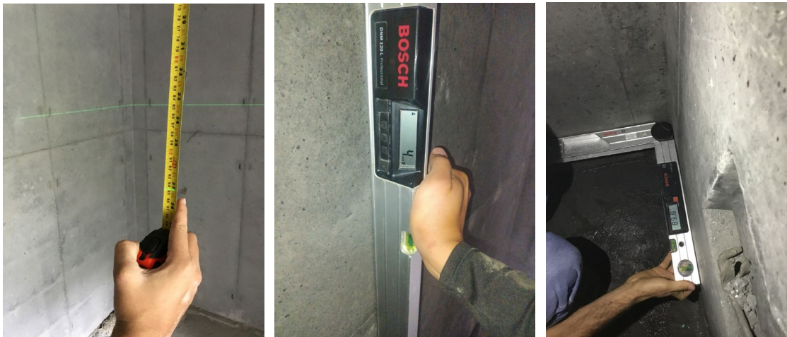
Figura 26. Revisión de tolerancia en elementos estructurales, obra Villa Gabriela ( Elaboración propia ).
