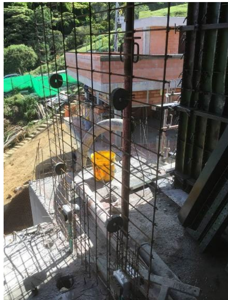
Figura 21. Llegada de tubería principal al punto de vaciado por método flujo inverso (Elaboración propia).
