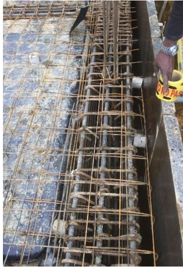
Figura 16. Revisión de elemento estructural en la obra Villa Gabriela (Elaboración propia).
