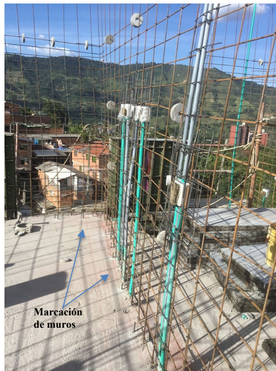
Figura 10. Marcación de muros estructurales en el proyecto Villa Gabriela (Elaboración propia).
