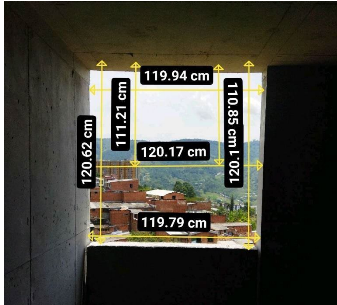
Figura 15. Medidas del vano en ventana de la obra Villa Gabriela (Elaboración propia).
