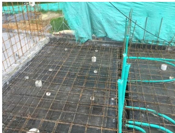
Figura 17. Disposición de panelas en losa de obra Villa Gabriela (Elaboración propia).
