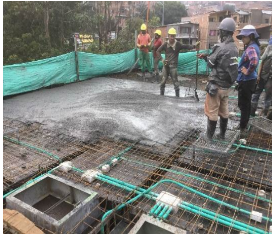
Figura 24. Flujo del concreto autocompactante en vaciado flujo inverso (Elaboración propia).
