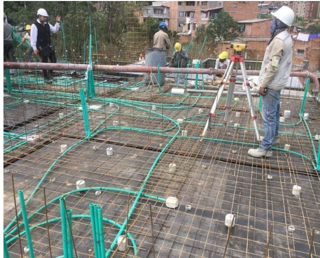
Figura 13. Medición de horizontalidad con el nivel topográfico en el nivel superior de la losa (Elaboración propia).
