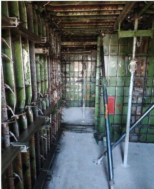
Figura 11. Elementos del encofrado en la obra Villa Gabriela (Elaboración propia).
