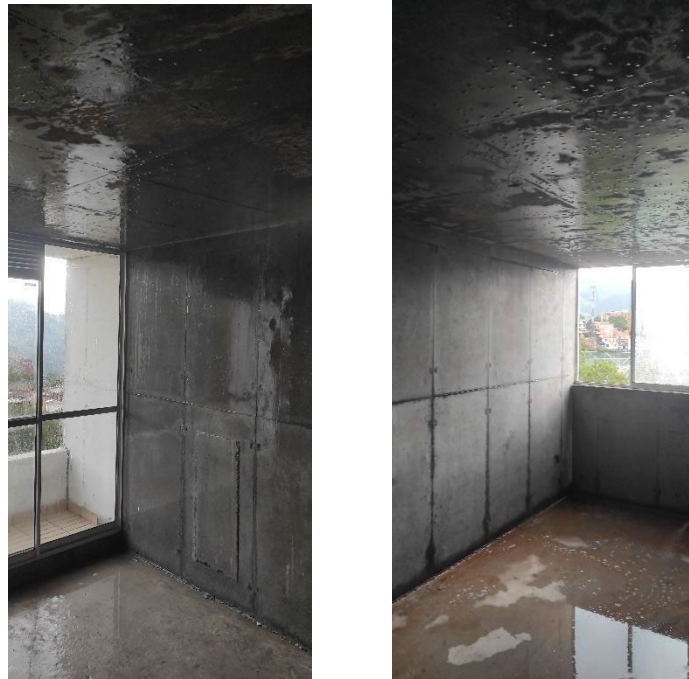
Figura 25: Curado de la infraestructura post vaciado de concreto (Elaboración propia).
