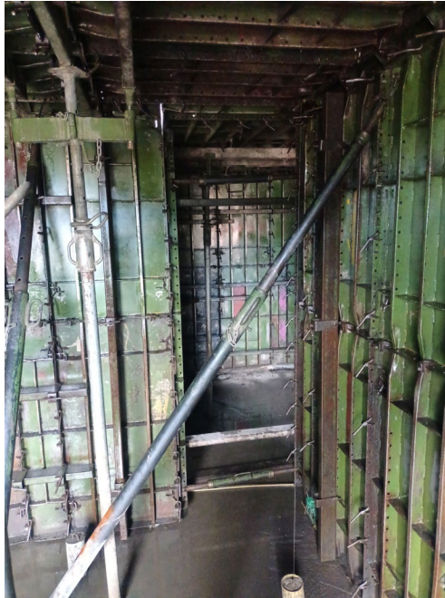
Figura 14. Medición de verticalidad en obra mediante plomada (Elaboración propia).
