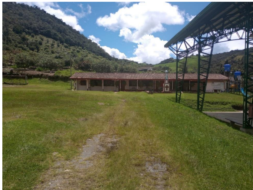
Foto 25 Planta física CER Llanadas
