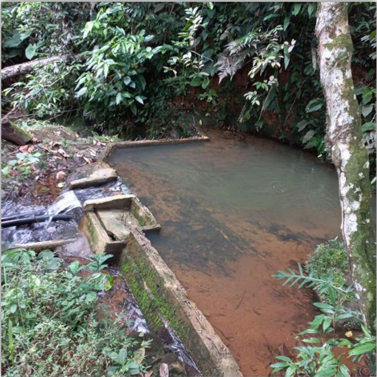
Figura 18. Bocatoma individual, presa de derivación para estanques de peces
