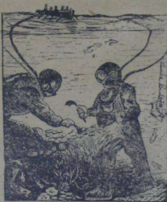
En algunos lugares, para facilitar la pesca de perlas se usa el escafandro, extraño traje que les permite a los buzos respirar sin salir del agua. La parte superior la forma un casco que les cubre por completo la cabeza, al cual va sujeto un tubo que comunica con el aire exterior. Los tripulantes de la embarcación de donde ha bajado el buzo, por medio de una bomba hacen pasar el aire por el tubo que lo conduce al interior del
