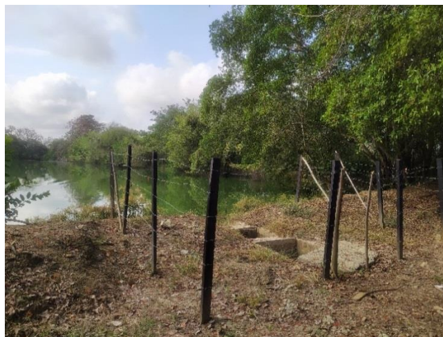
Figura 5. Cerco de la estructura de la laguna de oxidación.
