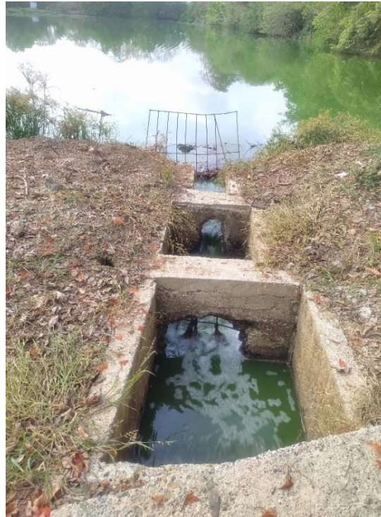
Figura 4. Estructuras de la laguna de oxidación.
