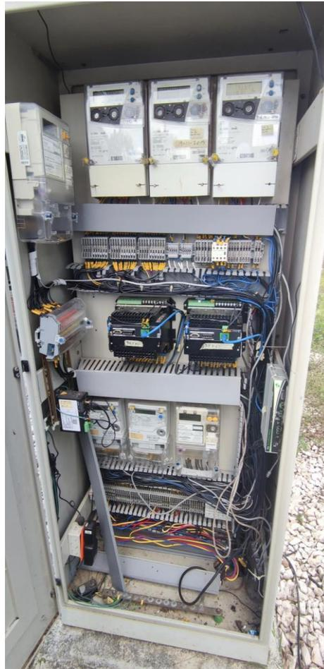
Figura 34. Tablero medidores circuitos y SSAA 13.8kV.
