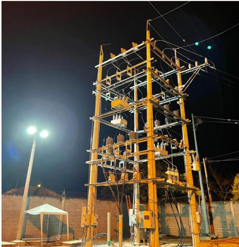
Fig. 39. Pórtico de llegada 34,5kV
