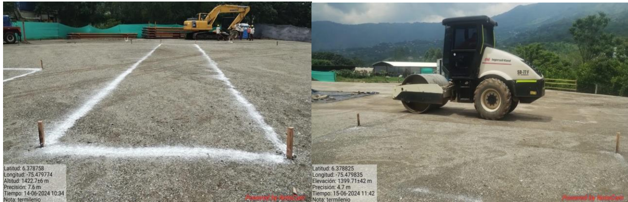
Adecuación de un terreno con material granular de RCD en Girardota
