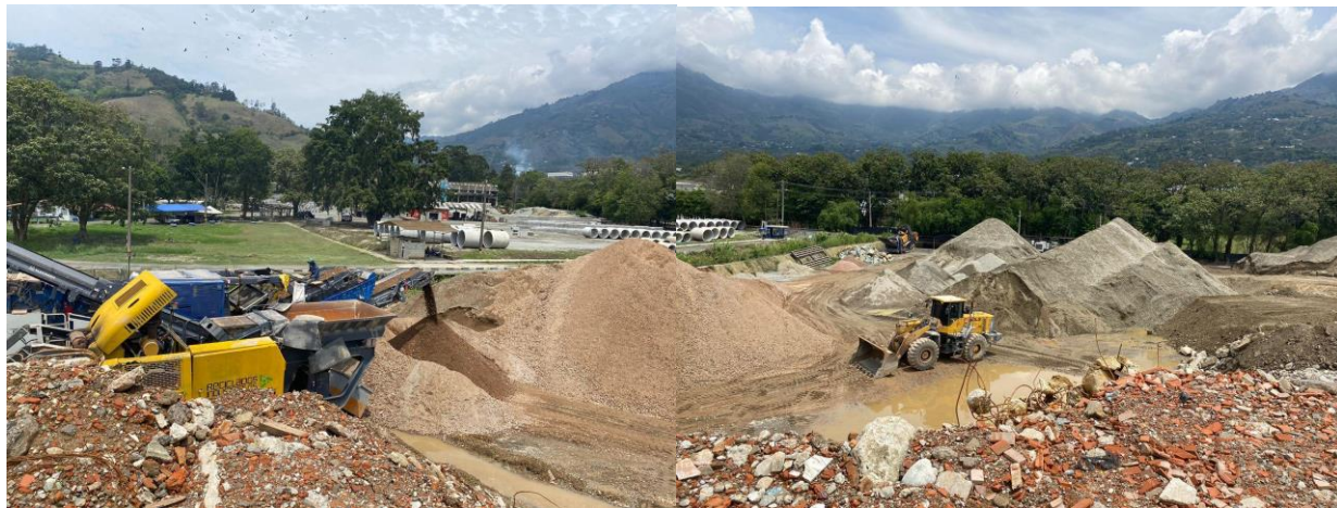
Planta de Reciclados Industriales de Colombia
