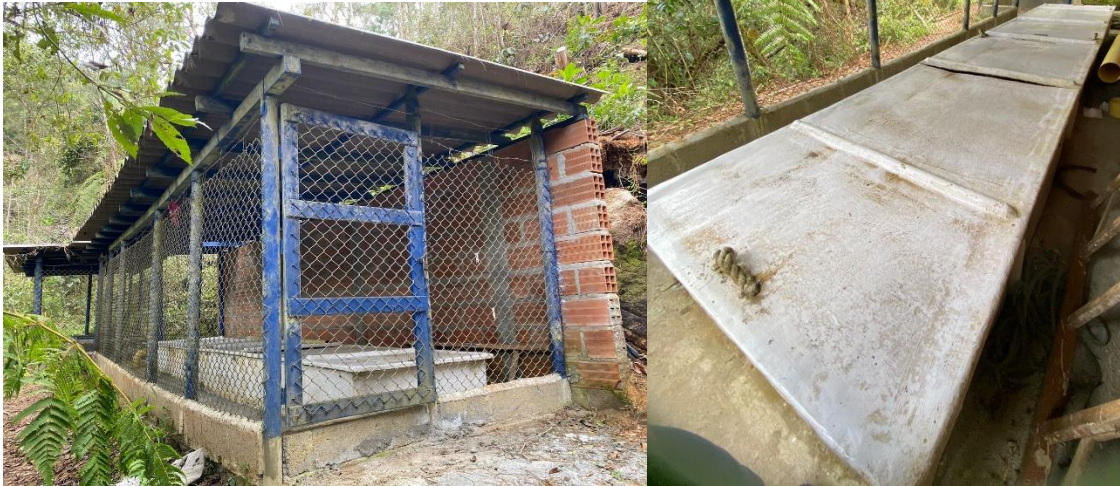
Desarenador Bocatoma el Volantín
