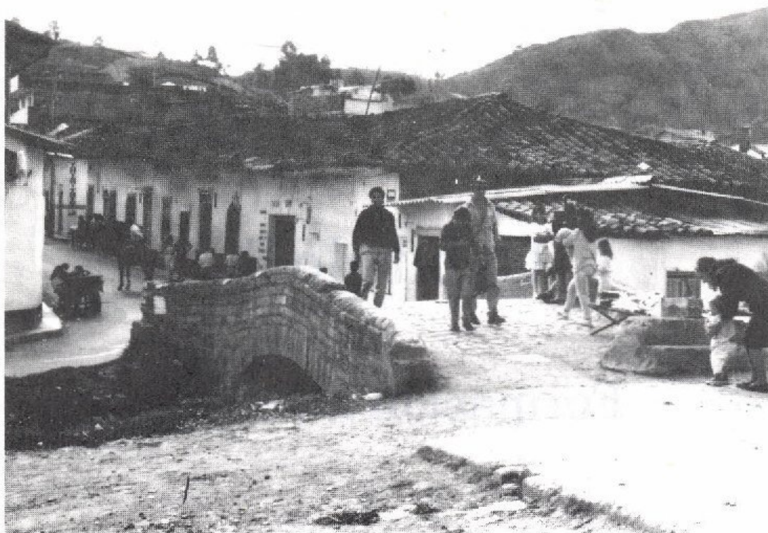
El puente del centenario o "Puente Roto" es uno de los pocos monumentos históricos que se conservan.
