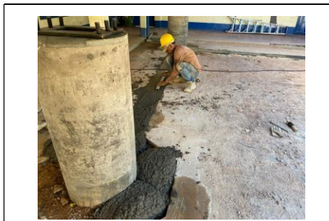
FOTO 5 Relleno en receo comun compactado mecánicamente para losa de concreto de 21 MPA
