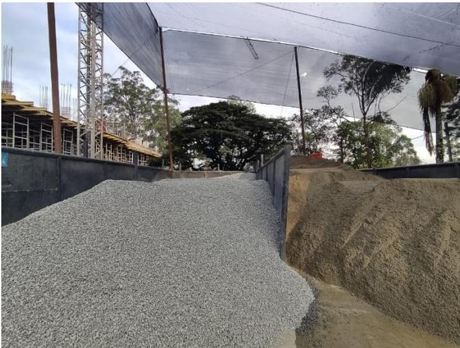
Es importante tener espacio suficiente en el chiquero a la hora de depositar un cargamento de agregado, pues de lo contrario es posible que parte del material quede por fuera y se contamine con tierra, como muestra la **Figura 2**, y ya no pueda utilizarse. Ambos chiqueros tienen una medida aproximada de 8m de largo, 4m de ancho y 1.95m de alto.
