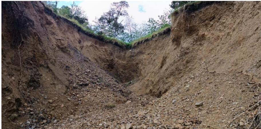
**Fotografía 5.** *Infraestructura vial afectada por un proceso erosivo tipo cárcava, municipio de Amagá.*
