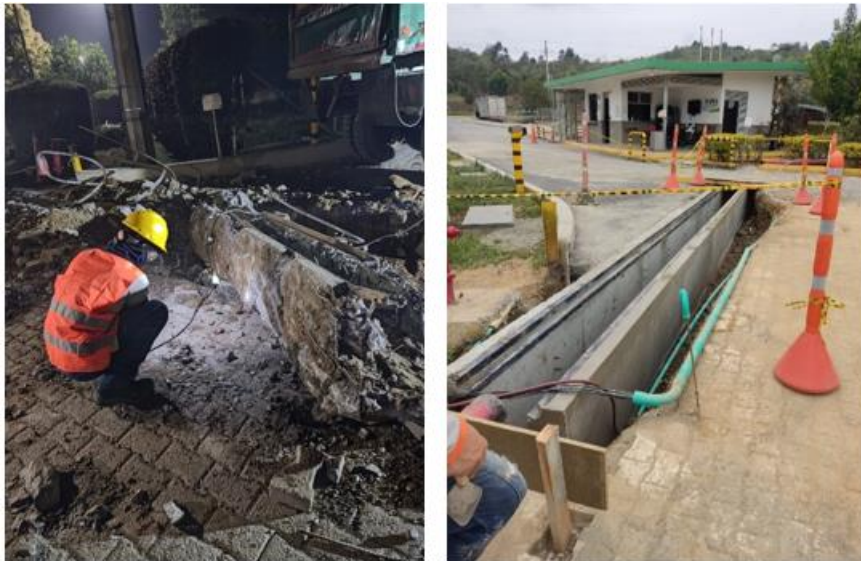
Figura 11. Demolición de cárcamo actual y construcción del nuevo. Fuente: elaboración propia.
