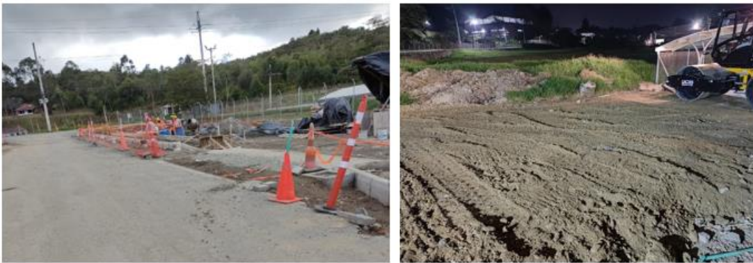
Figura 9. señalización y adecuación de botadero. Fuente: elaboración propia.
