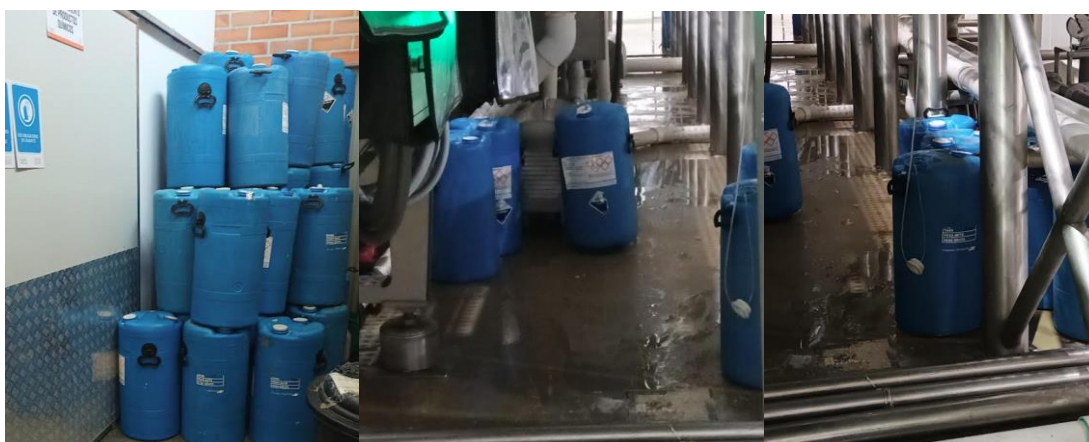
Figura 19. Almacenamiento de bidones vacíos inadecuado (derecha y centro) y adición de hipoclorito al proceso por medio de bomba de diafragma abierta al ambiente y generando gases y vapores (izquierda).
