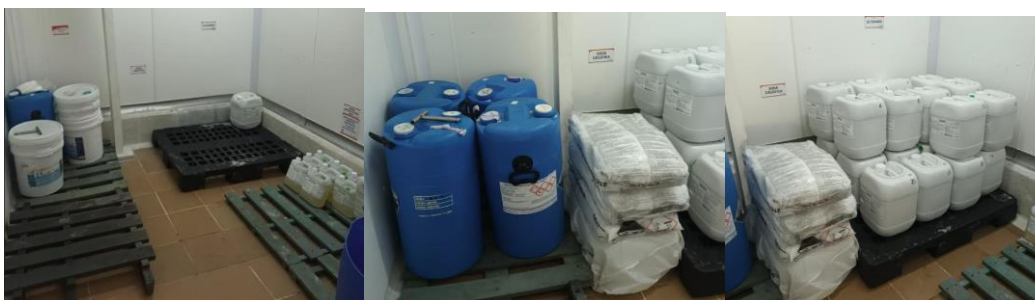
Figura 14. Cuarto de almacenamiento de sustancias químicas de aseo y desinfección-Calidad sin compatibilidad, sin diques y estanterías.
