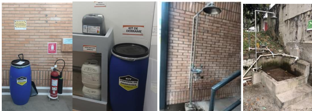
Figura 12. Elementos de seguridad dispuestos en los lugares donde se almacenan sustancias químicas.
