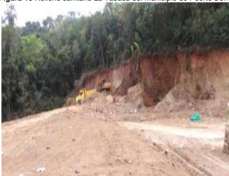
Figura 10 Relleno sanitario La Tabaca del municipio de Puerto Berrio
