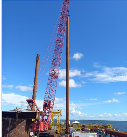
Figura 7 Proceso de verticalización de pilotes.
