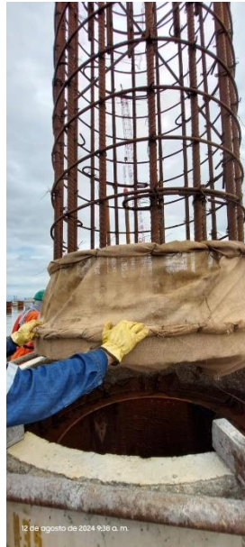
Figura 14 Instalación de fique en la parte inferior del refuerzo del plug.
