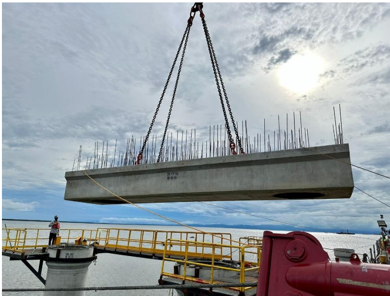
Figura 16 Izaje de cap beam sobre la sleeve.
