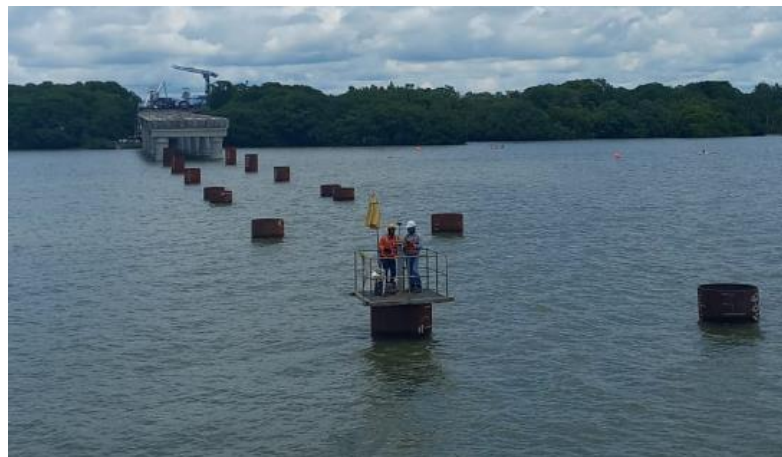
Figura 9 Hincado de pilotes hasta cota de diseño.
