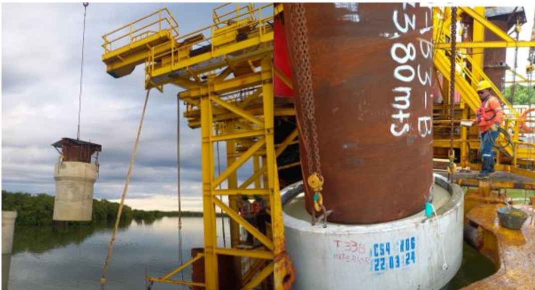
Figura 12 Izaje e instalación de sleeve con spreader.
