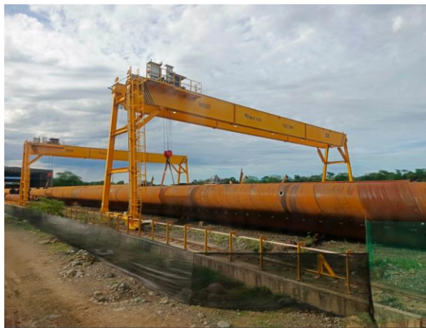
Figura 4 Planta de fabricación de pilotes en COTEMA.
