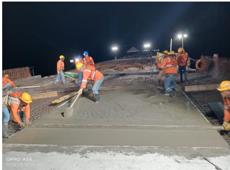
Figura 32 Proceso de fundición de losa.
