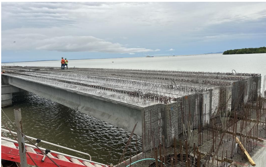
Figura 20. Proceso de instalación de vigas pretensadas.
