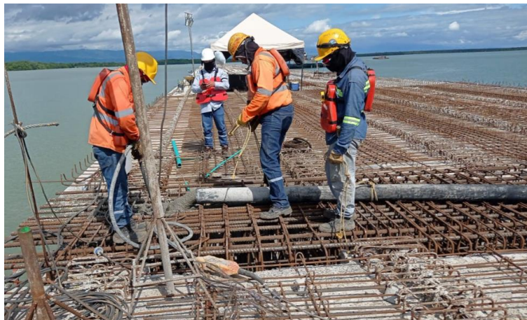
Figura 26 Proceso de fundición de cap beam in situ.
