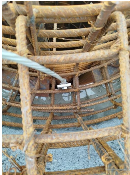
Figura 15 Instalación de platina y guaya para protección catódica.
