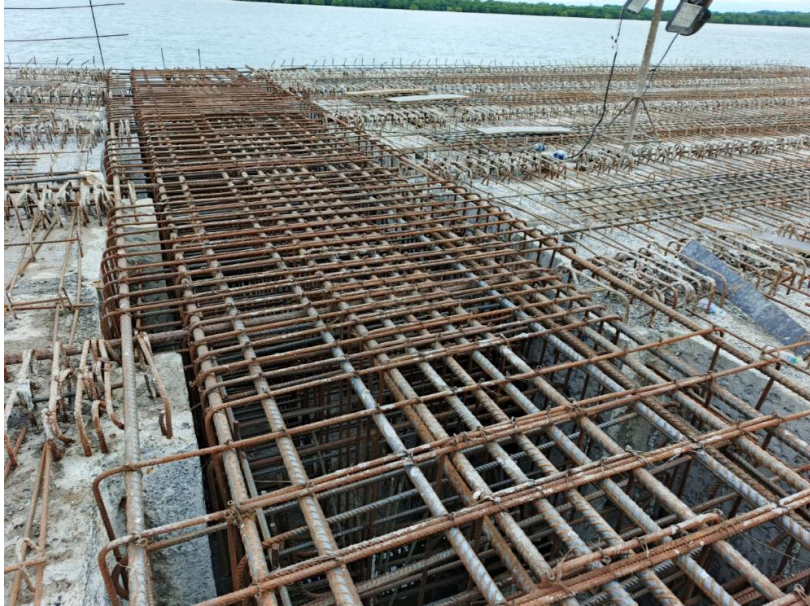
Figura 23 Instalación de acero de refuerzo de viga in situ.
