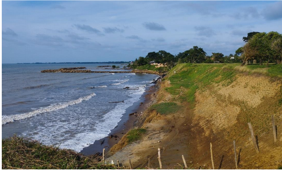
Figura 2. Laboratorio costero. Talud modificado mediante su perfilamiento.
