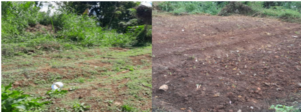
Fotografía 12 Antes y después de la adecuación del terreno
