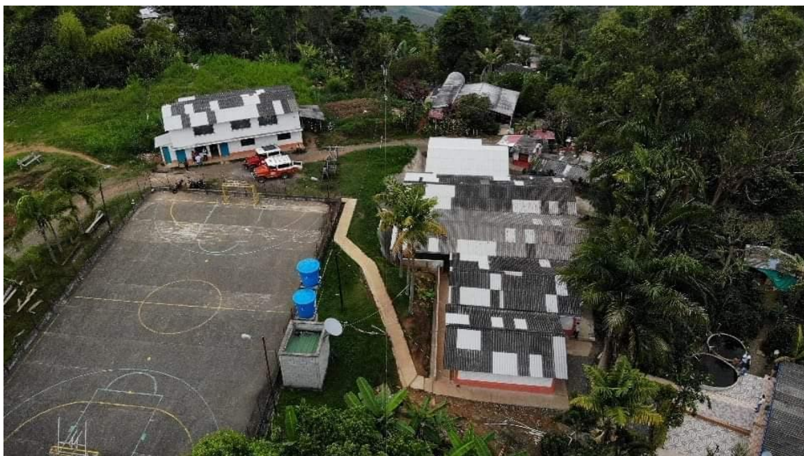
Fotografía 2 Vista área del C.E.R Yarumal
