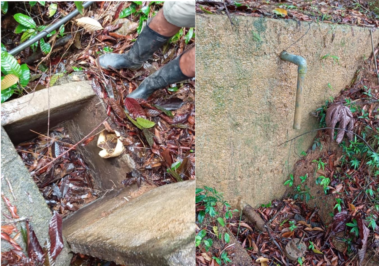
Bombeo de pozo
