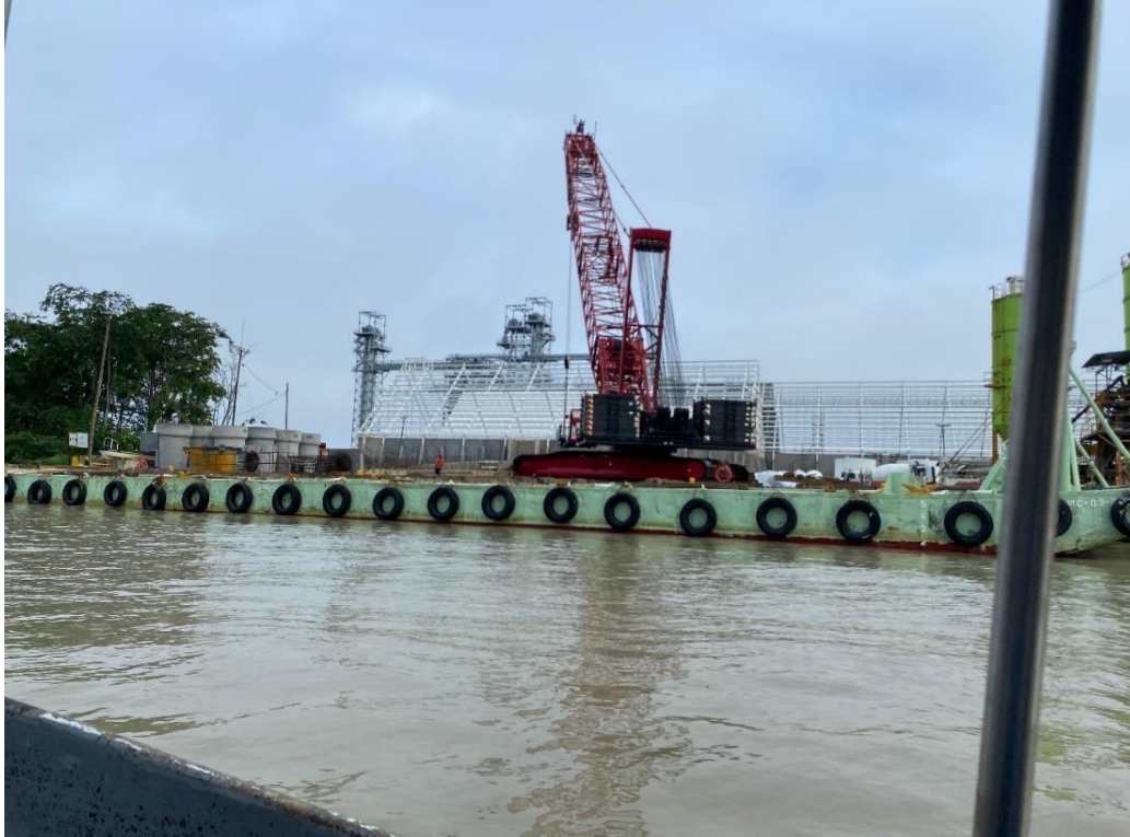
Ilustración 25. Cargue de material a la barcaza Leo VI. Fuente: Elaboración propia.
