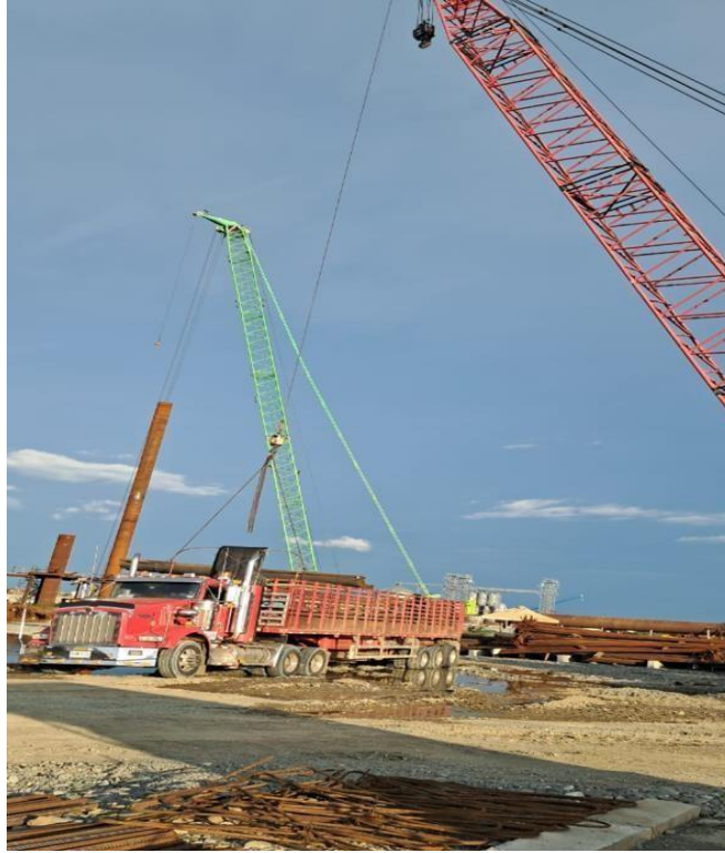
Ilustración 6. Grúa celosía en patio de acero. Fuente: Elaboración propia
