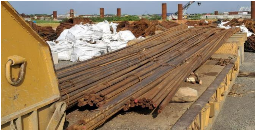
Ilustración 19. Transporte de acero longitudinal sobre cama baja. Elaboración propia.
