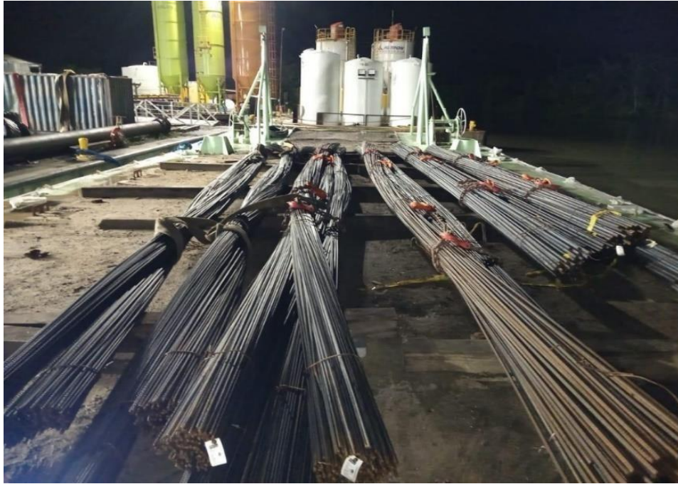
Ilustración 28. Paquetes de acero con eslingas de cadenas. Fuente: Elaboración propia.
