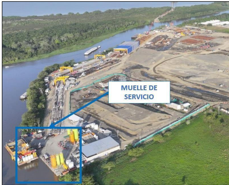
Ilustración 24. Ubicación de muelle de servicio en el megaproyecto. Fuente: Cotema.
