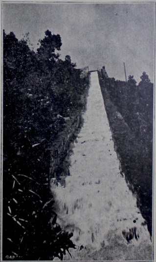
MEDELLIN PINTORESCO.—Expléndida cascada artificial que forma el desagüe del Tanque de la Planta Eléctrica Municipal y del Acueducto de Medellín en el Alto de «El Toldo», al nordeste de la ciudad.
