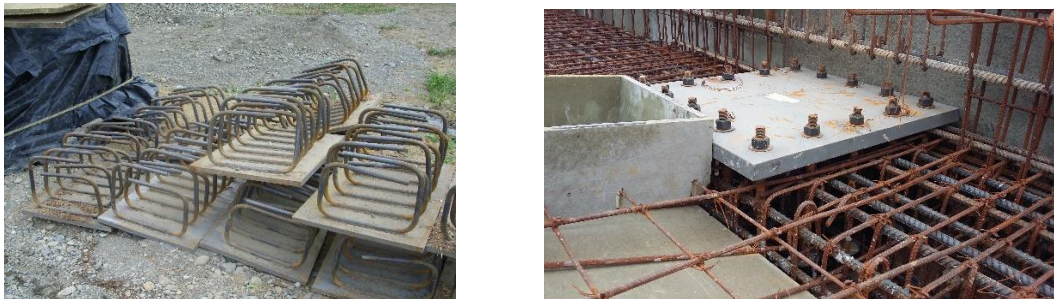
Figura 1. Diferentes sistemas de anclajes (Fuente: Estructuras metálicas Delacero sas).
