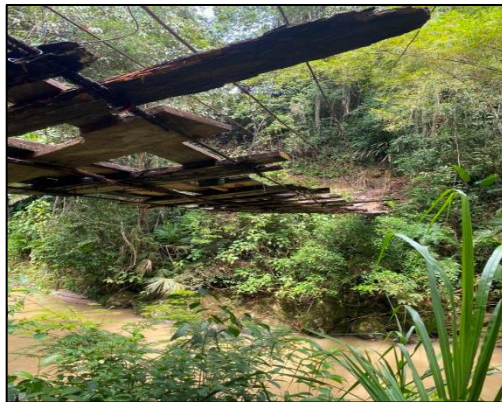
Imagen 5. Infraestructura del puente. Vereda Rio Blanco
