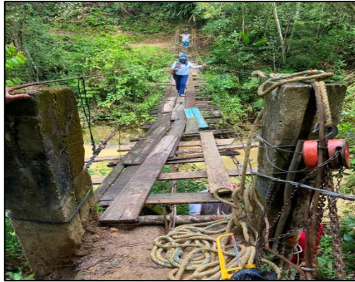
Imagen 4. Infraestructura del puente. Vereda Rio Blanco
