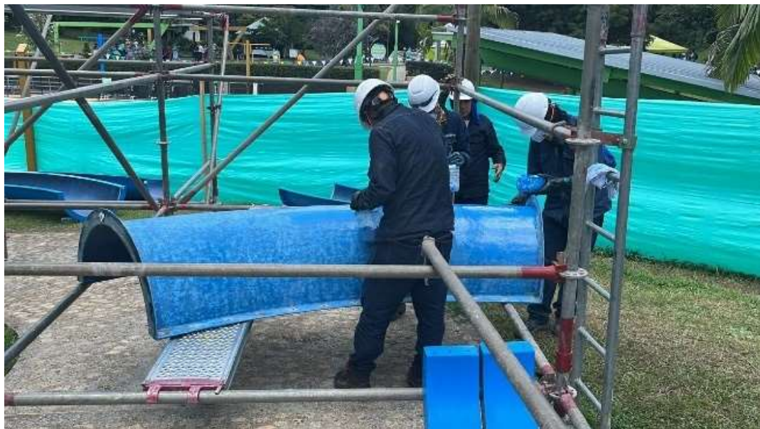
Ilustración 4: Aplicación de pintura
