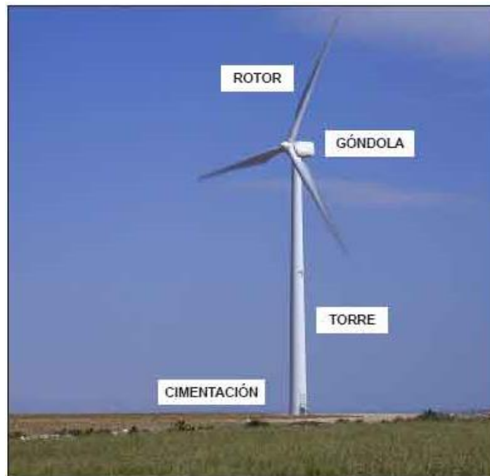
Ilustración 4. Partes principales de un aerogenerador.
