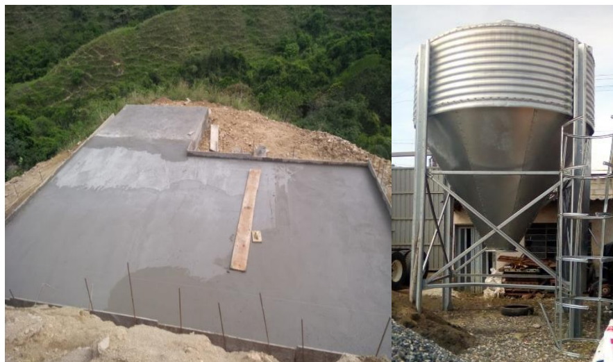
13. Losa y silo de alimentación.
