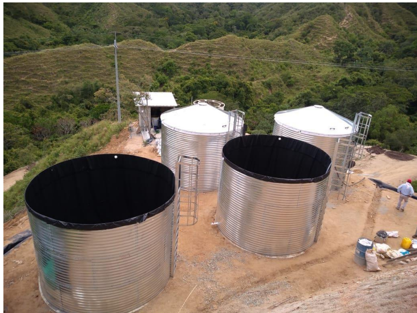
9. Tanques de almacenamiento de agua potable.
