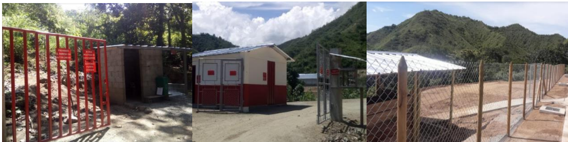
15. Caseta de portería, portada y cerramientos en malla eslabonada.
