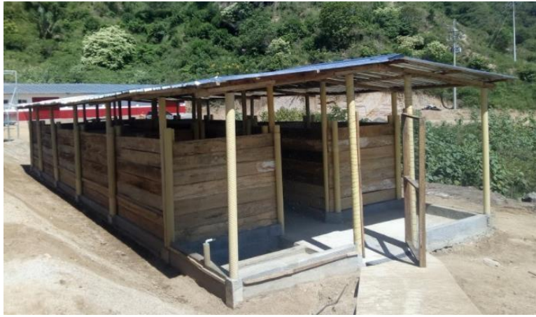
8. Compostera fabricada con tablas de madera, tubos sanitarios y guadua.
