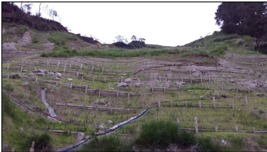
Imagen 4. Instalación de trinchos y obras de drenaje en talud. Fuente: Geosfera SAS
