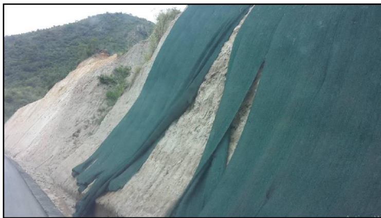
Imagen 6. TRM500, un año después de la instalación, vía Caucasia-Zaragoza. Fuente: Geosfera SAS
