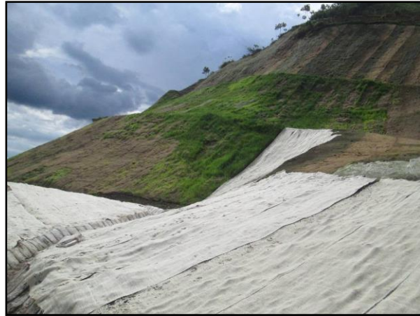
Imagen 12. Taludes con un agro textil de fibras de fique, protegen el biomortero rico en semillas de pasto. El Hormiguero, vía Santafé de Antioquia. Fuente: Geosfera SAS
