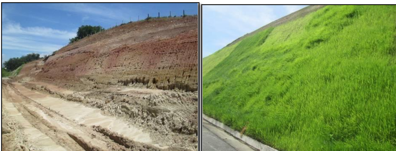
Imagen 14. Empradización con biomortero rico en semillas de pasto. Ruta del Sol. Fuente: Geosfera SAS
