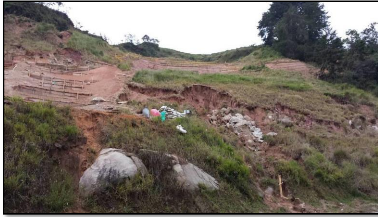
Imagen 3. Deslizamiento superficial Km 8+950 vía Hatillo-Don Matías. Fuente: Geosfera SAS
