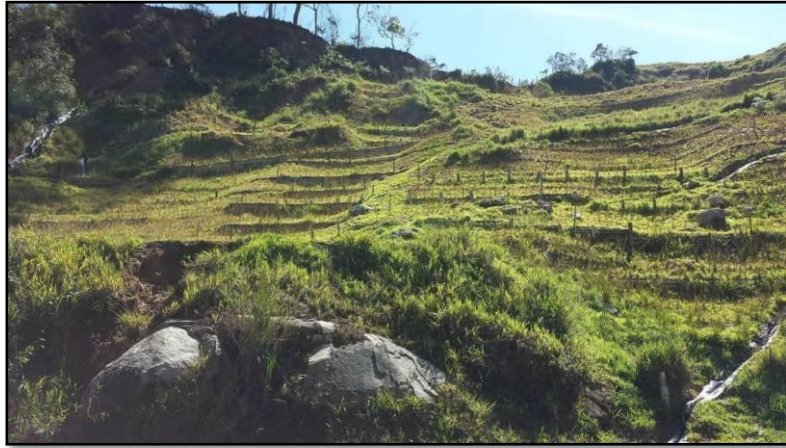
Imagen 5. Resultado final estabilización Km 8+950 vía Hatillo- Don Matías. Fuente: Geosfera SAS
