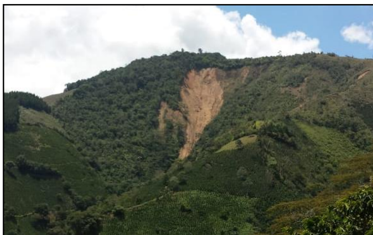
Imagen 2. Erosión en cárcava. Vía Quibdó. Fuente: Propia
