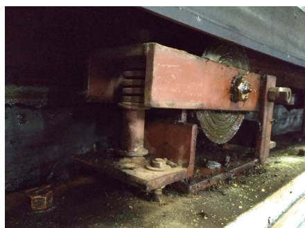
Figura 12: Soporte vertical domo.
