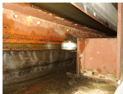
Figura 13: Soporte radial domo.
