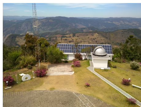
Figura 29: Visita desde el observatorio del pararrayos.
