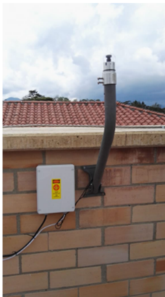
Figura 63: Montaje general, solo se requiere potencia eléctrica y un cable de red.
