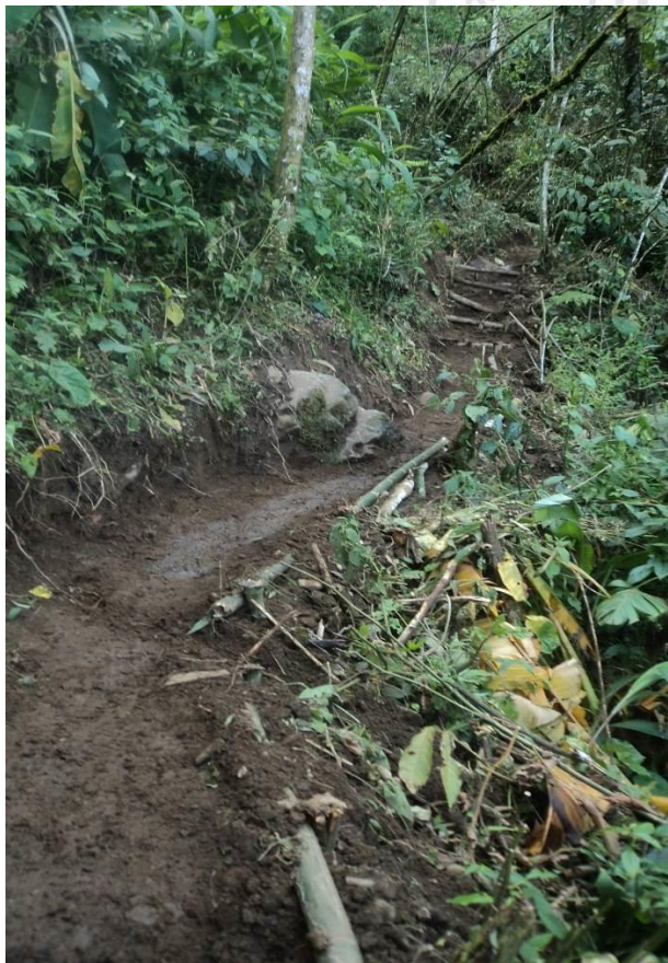
Fotografía 3. Adecuación de camino de acceso.
