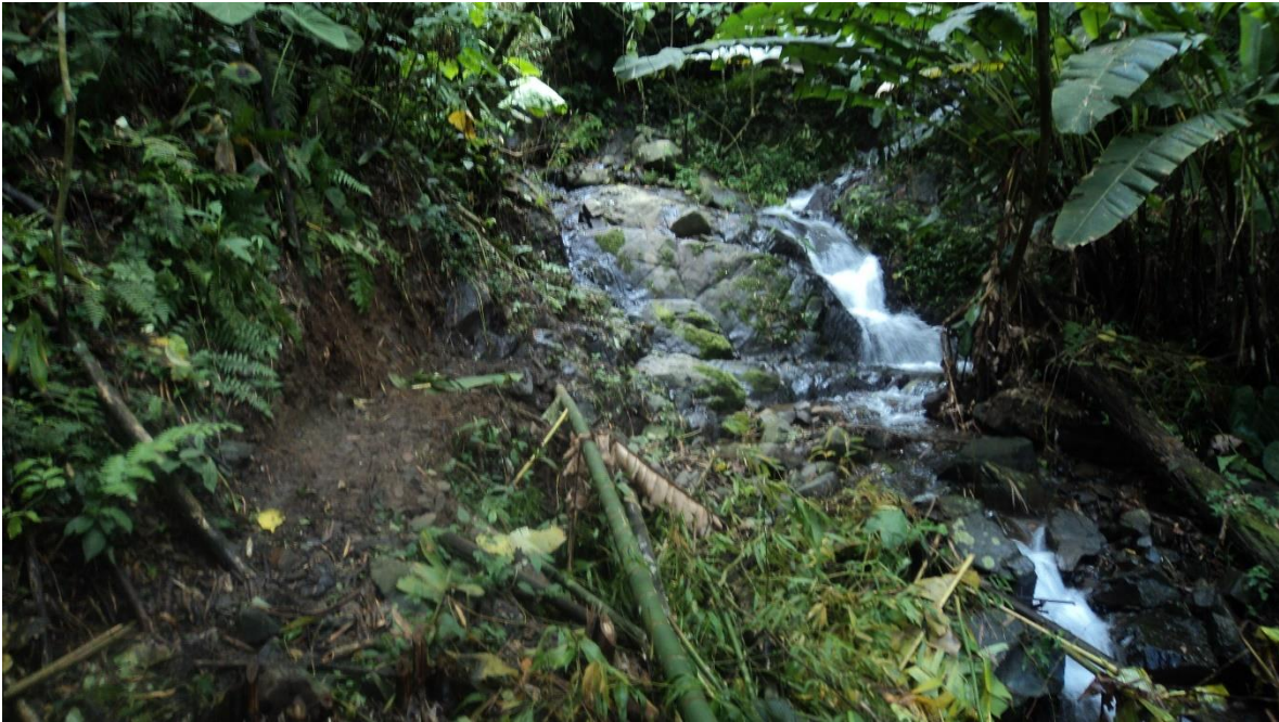
Fotografía 2. Rocería en punto bocatoma
