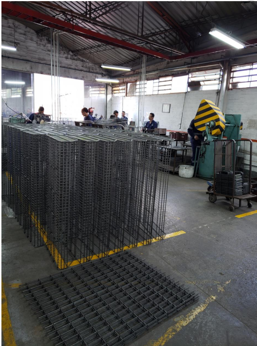
Ilustración 28. Avance de adecuaciones en la sección de la línea de fabricación 1. Elaboración Propia
