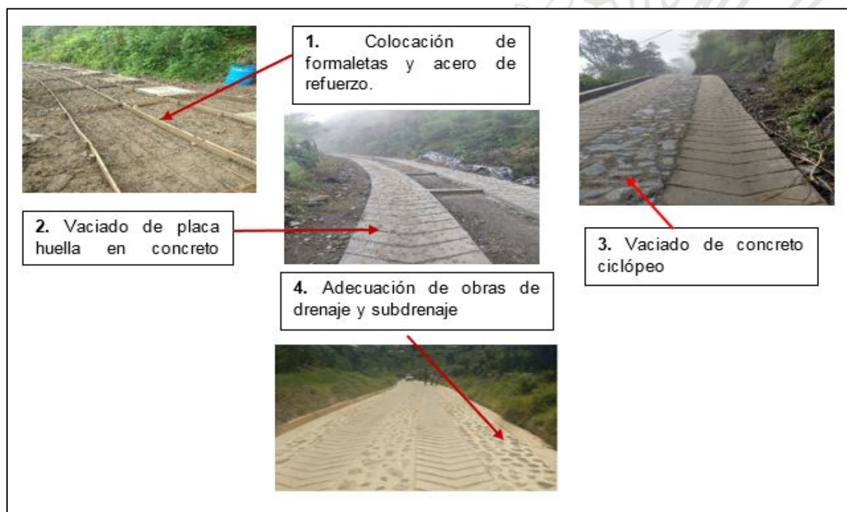
Ilustración 7 Proceso constructivo de la placa huella.
