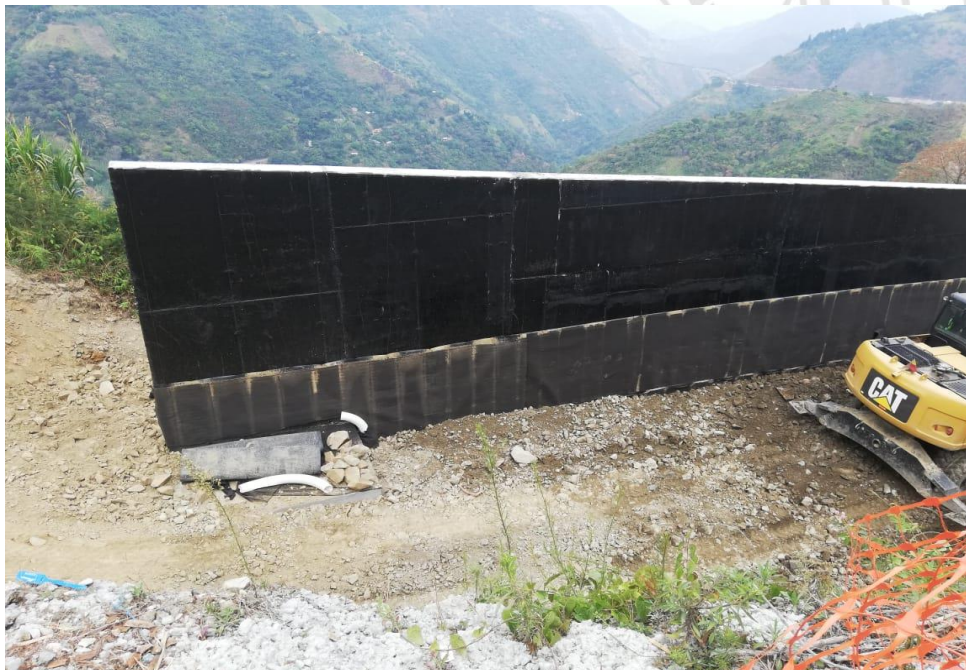
Ilustración 15: Lamidren L7 muro de contención.
