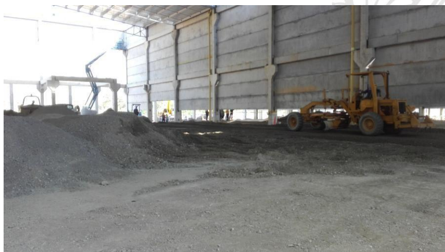
Imagen 20. Extendido de Material de Base granular.
