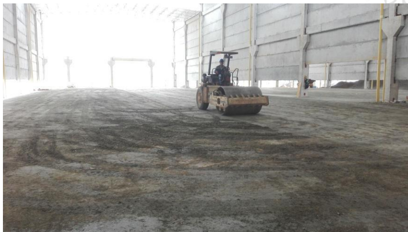
Imagen 22. Compactación del suelo.
