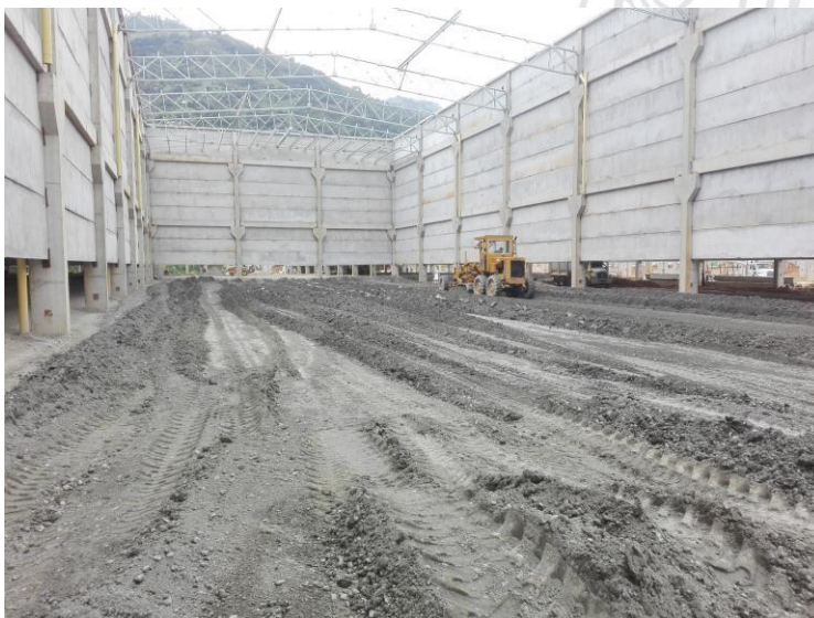
Imagen 26. Escarificado del material para reducir humedad.
