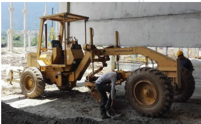
Imagen 2. Motoniveladora Caterpillar 120k
