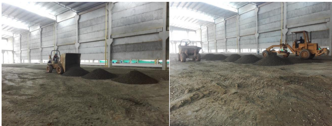
Imagen 25. Distribución estratégica del material para reducir el tiempo de extendido.
