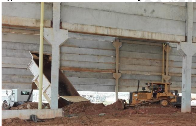
Imagen 19. Extendido de material para subrasante.
