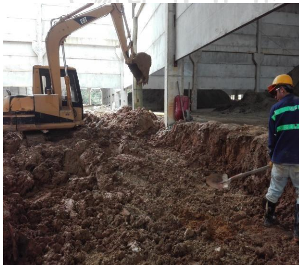
Imagen 12. Excavación de Fallo.
