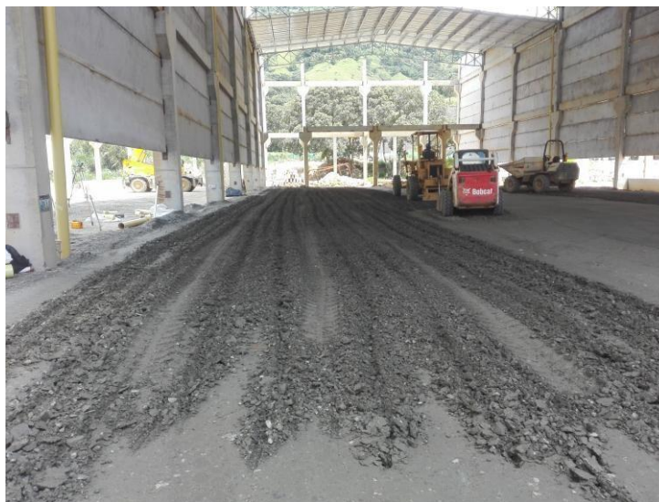
Imagen 21. Escarificado para reducir humedad.
